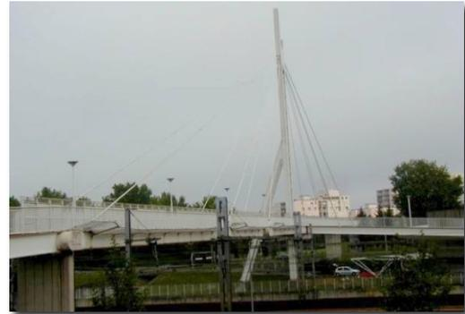
Figure 7. Cas d'une passerelle piéton haubanée instable par amortissement en torsion simple et en flexion simple (avant modifications constructives)
