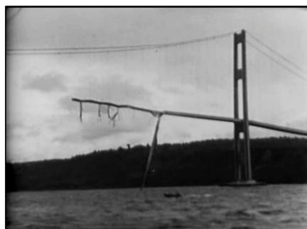
Les ponts suspendus sont très souples car le tablier (la chaussée) est suspendu au bout de câbles. S'il souffle assez fort le vent peut engendrer une petite déformation. Ici à l'évidence c'est une torsion du tablier qui est concernée.
