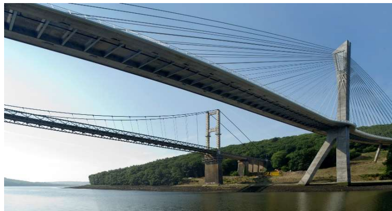
Figure 4. L'ancien (1952-2014) et le nouveau pont de Térénez (2011) (© photothèque Terra)
