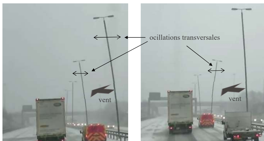
Figure 33. Un exemple de galop de candélabres
