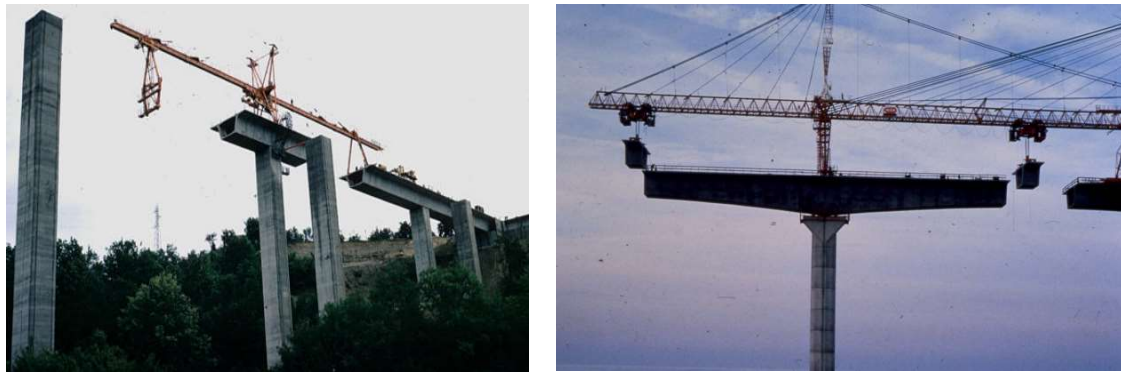
Figure 56. Quelques ponts construits par encorbellements successifs
