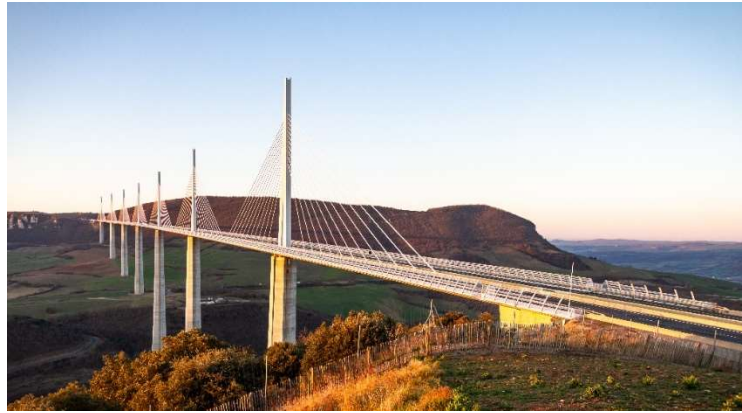
Figure 3. Le viaduc de Millau (© photothèque Terra)
