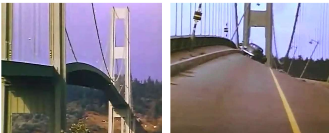
Figure 36. Le flottement de torsion du pont de Tacoma le jour de l'accident
