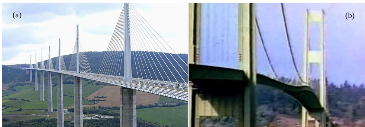
Figure 59. (a) Le viaduc de Millau. (b) Le pont de Tacoma le jour de l'accident
