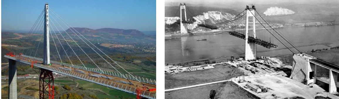
Figure 55. A gauche la construction du tablier du viaduc de Millau; ici en équilibre sur une palée provisoire (copyright photothèque Terra). A droite la construction du pont de Tancarville
